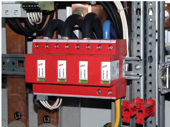
Bild 2 Blitzschutz-Potentialausgleich mit DEHNventil M
