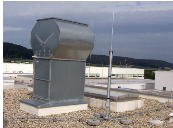
Bild 3 Isolierter Blitzschutz mit HVI-light-Leitung
